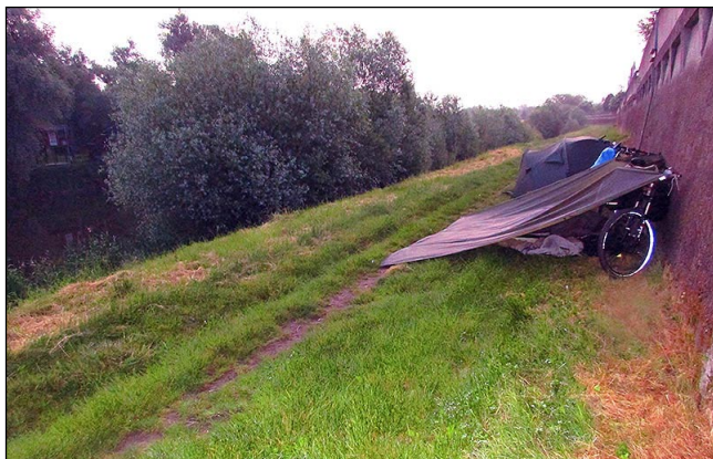
Vlevo pod cestou už je koryto Moravy
